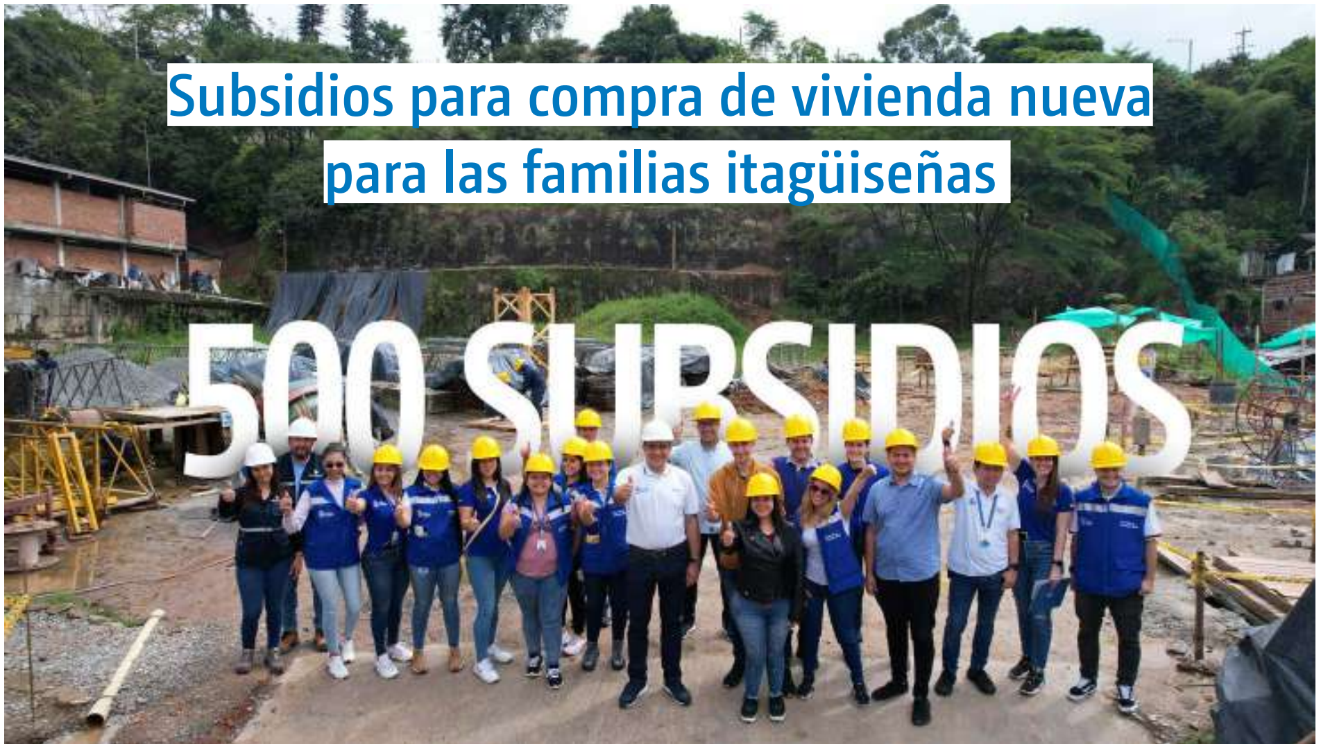
Inicio de obras proyecto Montefaro con familias beneficiadas con subsidio para compra de vivienda nueva
