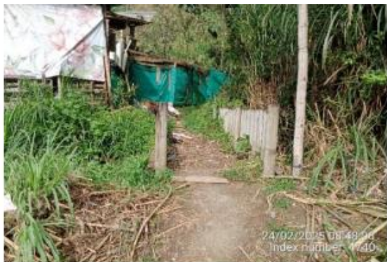
Imagen 1 Puente madera existente, inicio tramo
